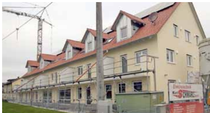
Die Arbeiten bei der neuen Demenzwohnanlage in Offingen liegen im Zeitplan: Im März wurde mit dem Bau begonnen, im Spätsommer nächsten Jahres wird sie bezugsfertig sein.
